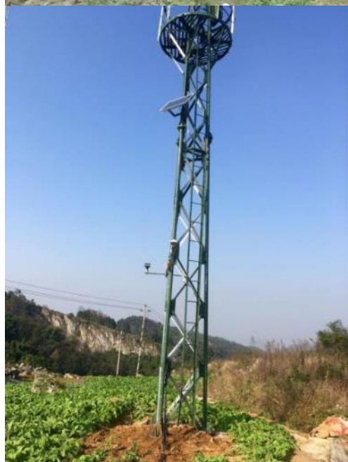
Automatic weather stations, eddy systems 自动气象站、涡动系统
